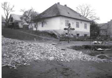
Gemeindehaus in der Karpato-Ukraine nach dem Hochwasser
